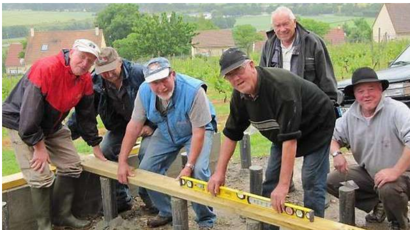
Construction de la cave du coteau de la Guesferie
